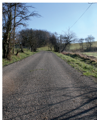
CHEMIN DU PUGNERET APRÈS TRAVAUX
