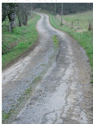
CHEMIN DU PUGNERET AVANT TRAVAUX
