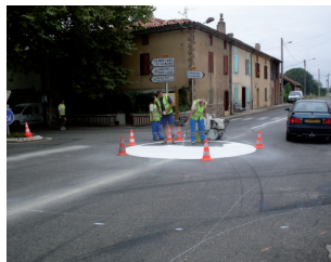
Mise en place
