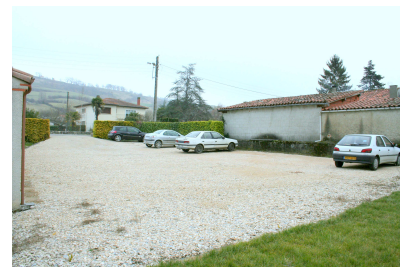
TERRAIN GARAGE APRES TRAVAUX
