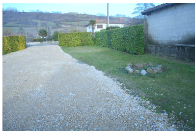
TERRAIN GARAGE AVANT TRAVAUX
