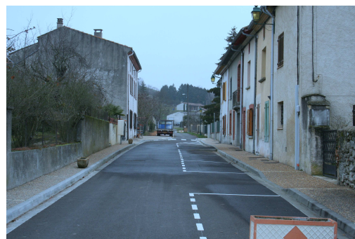
APRÈS EMBELLISSEMENT ET EFFACEMENT DES RÉSEAUX
