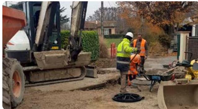
Travaux de pluvial rue des jardins afin de pouvoir mettre en place le réseau d'assainissement.
